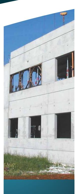
Agilia Vertical est un béton autoplaçant destiné au coulage de formes verticales complexes et/ou fortement ferraillées permettant l'obtention d'un parement amélioré.
